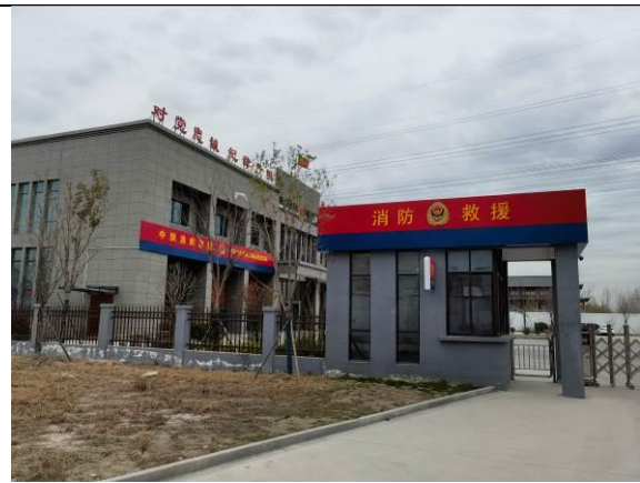
图 10 杨屯消防大队房屋 (E、B)
