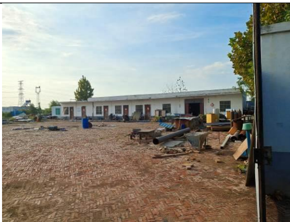
图 63 沛县中鑫农业科技公司房屋 (E、B)
