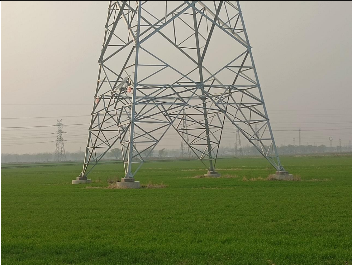
架空线路塔基处生态恢复照片
