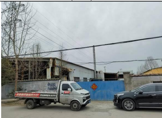
图 15 时口村北侧厂房（焚化厂厂房） (E、B)
