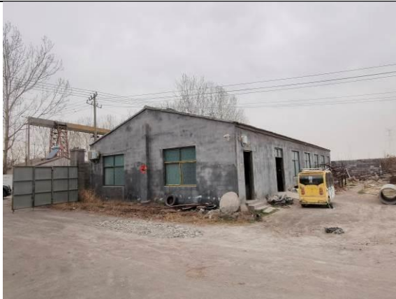
图 17 水泥管生产厂房屋 (E、B)
