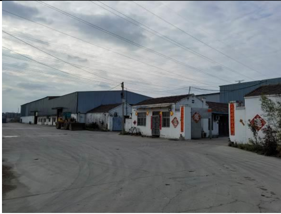
图 61 大屯铝业公司西侧厂房 (E、B)
