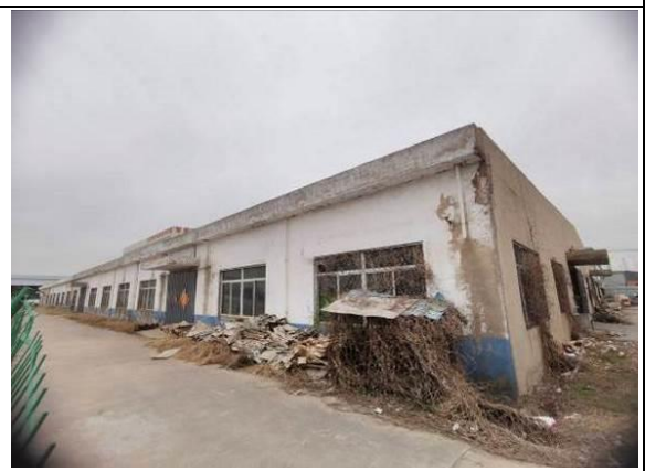
图 22 江苏新之翼交通运输设备有限公司厂房 (E、B)
