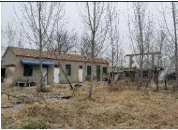
图 5 徐庄煤矿西侧养殖场看护房 (N)
