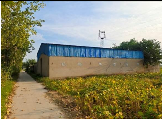
图 59 小马庄东侧废弃厂房 (E、B)
