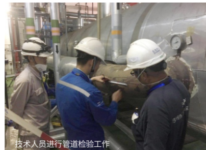
技术人员进行管道检验工作
