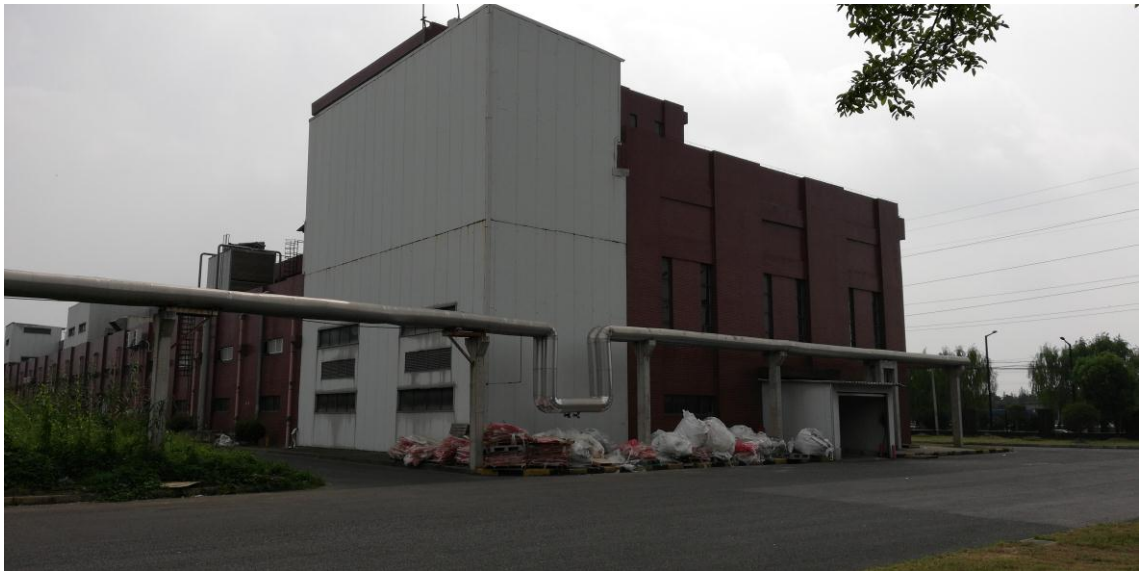
图 2、变电站东 28m 加料车间
