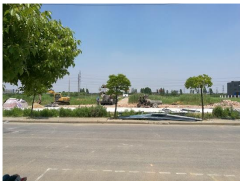
图 8-1 拟建加速器机房北侧厂界外道路
