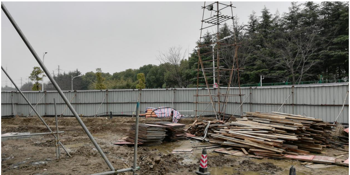
图 2-1、拟建村田变东南侧环境现状
