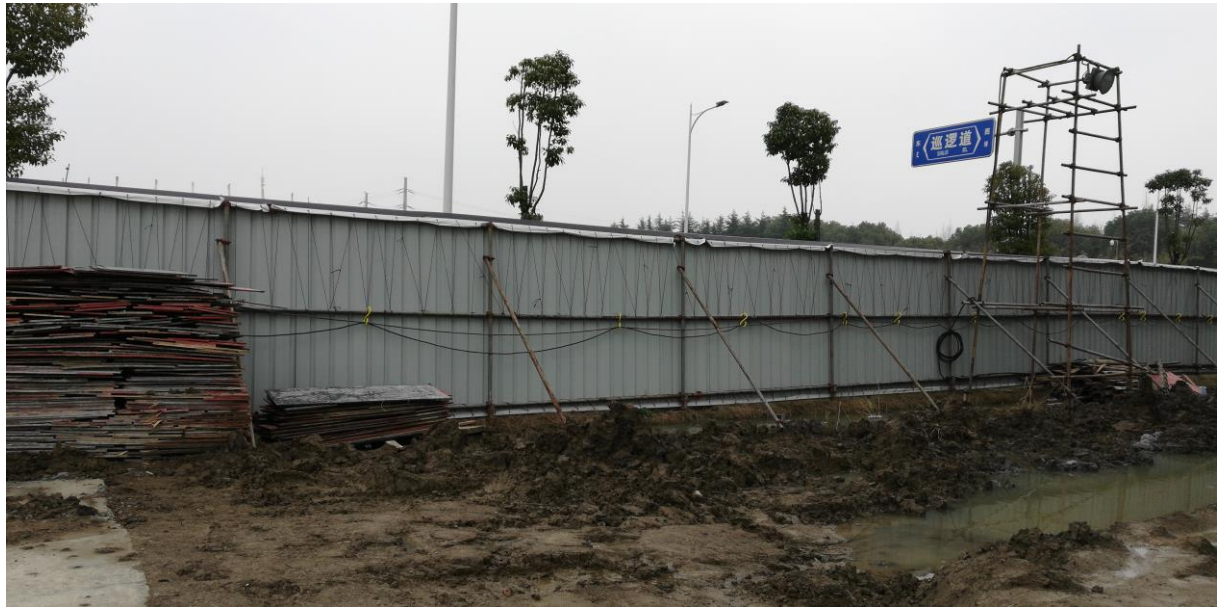
图 2-4、拟建村田变东北侧环境现状
