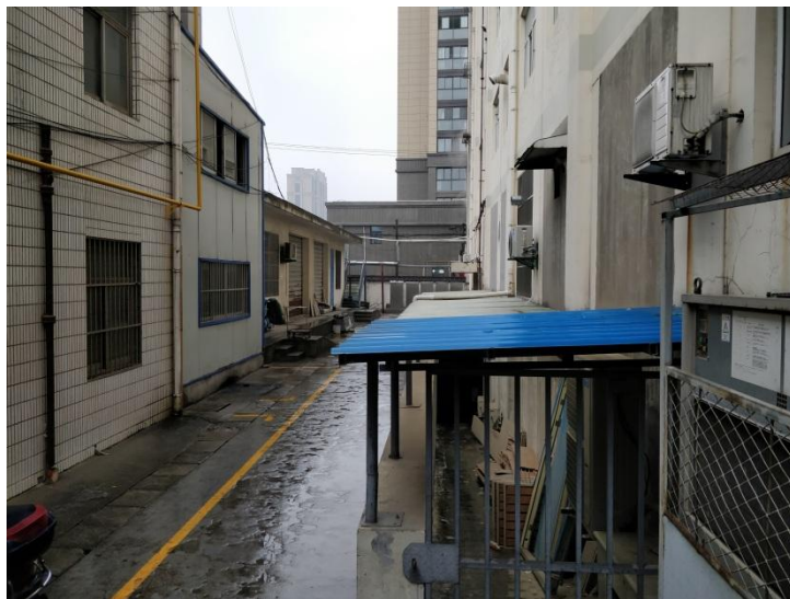
DSA 机房墙外北侧
