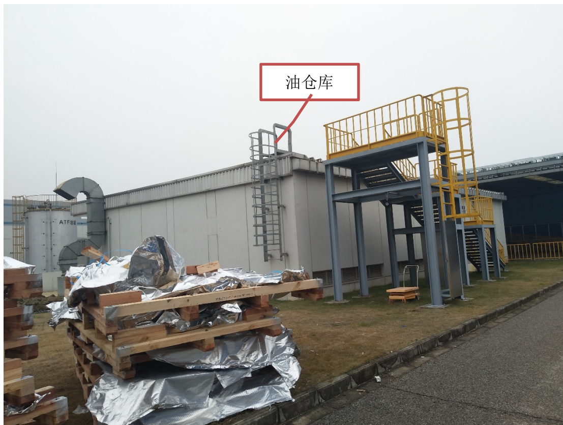
图 6-3 变电站北侧环境图
