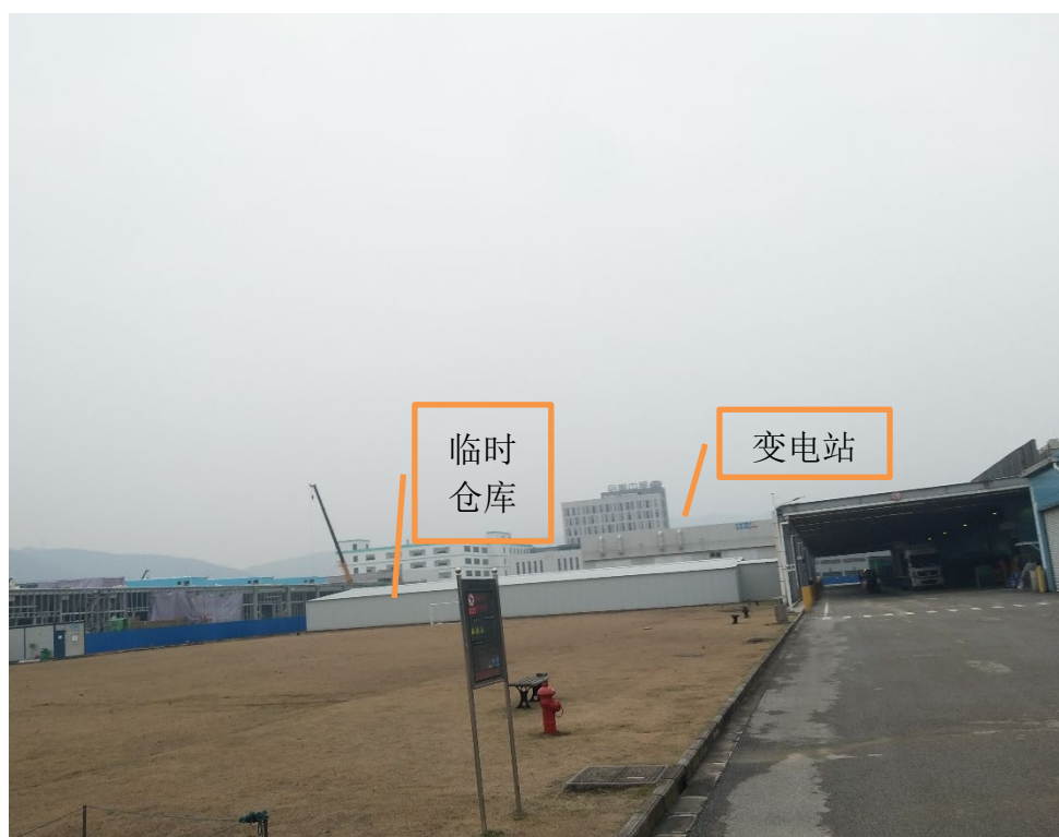
图 6-4 变电站西、南、东侧环境图
