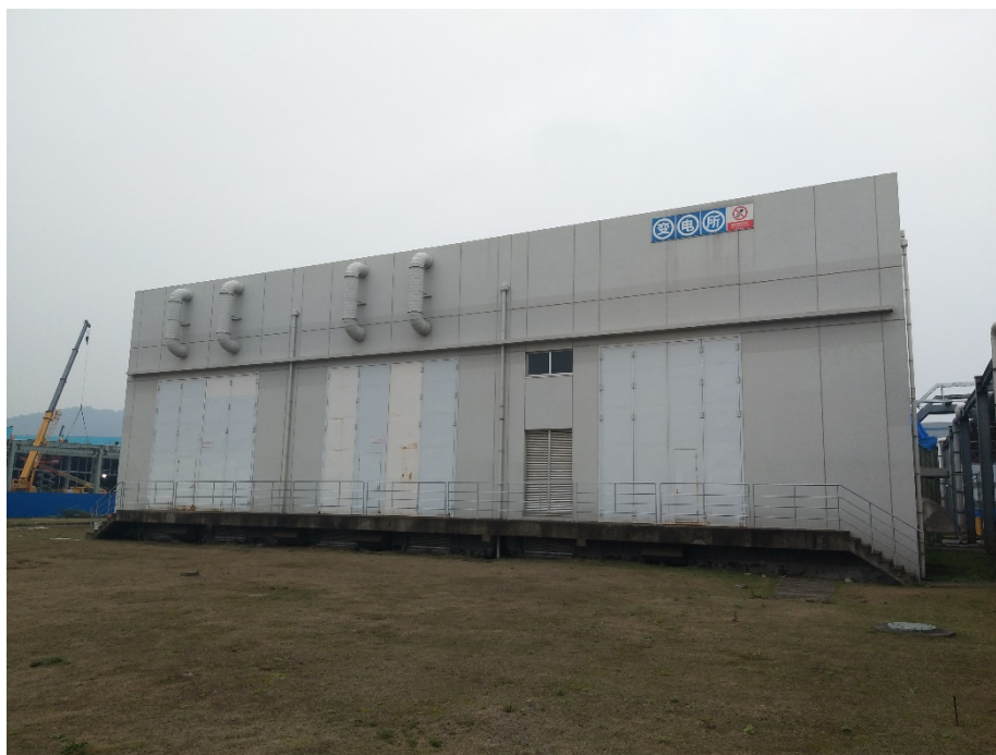
图 6-5 变电站整体图
