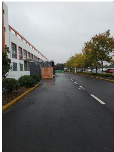
北侧道路、停车场
