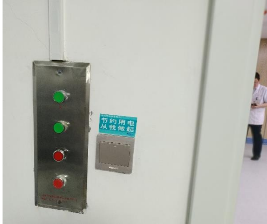
加速器机房内部分急停按钮和摄像头
