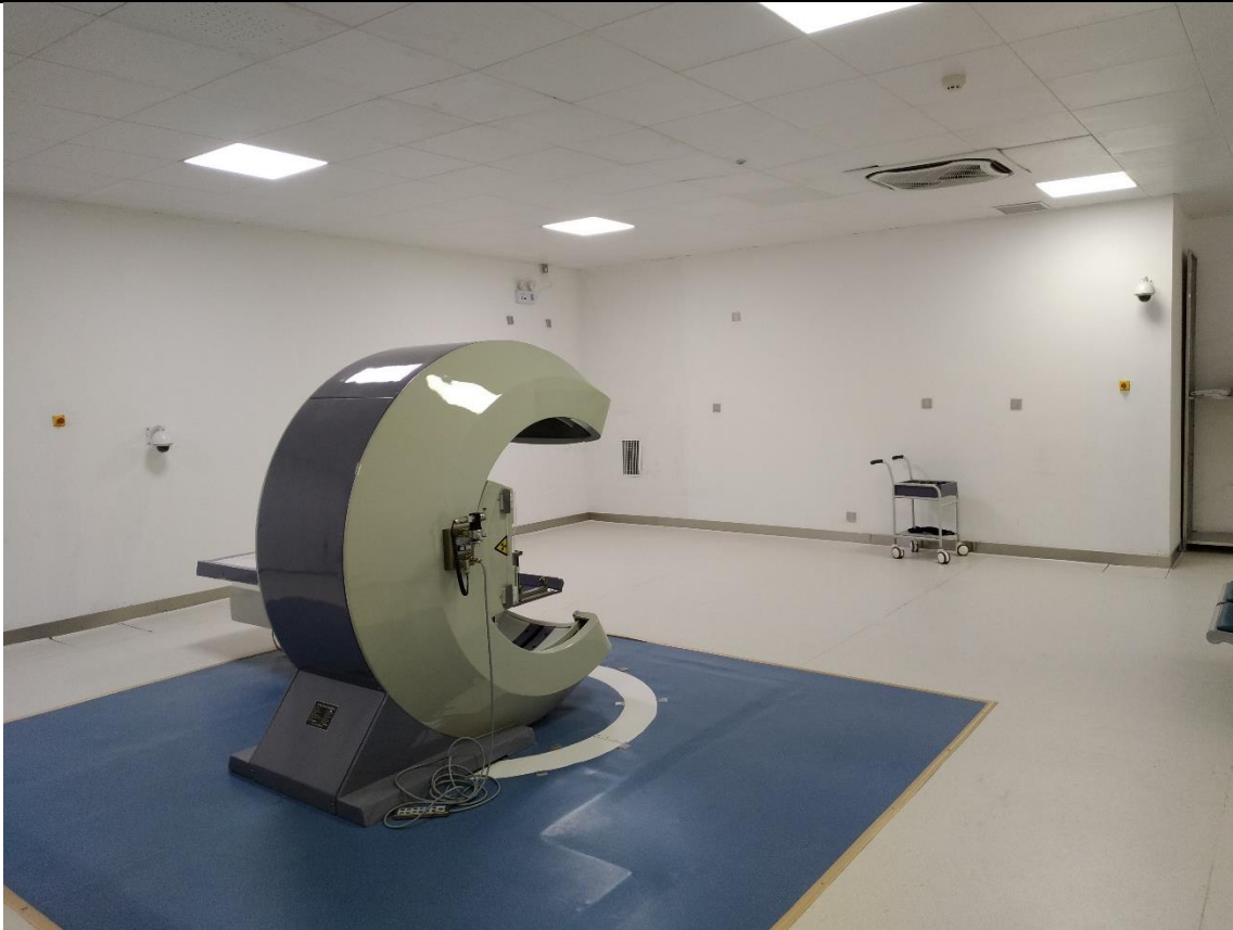
伽玛刀机房内急停按钮和摄像头
