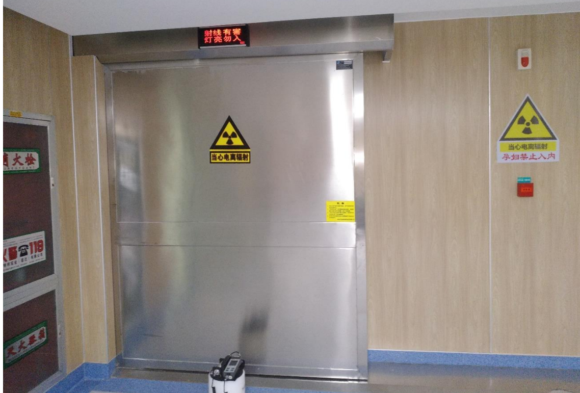
加速器防护门外工作状态指示灯及电离辐射警示标识
