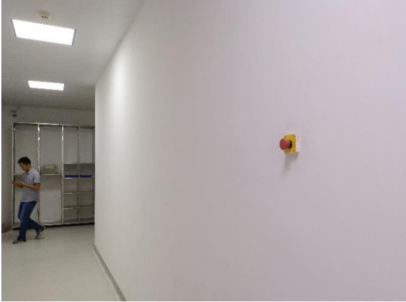
加速器机房内部分急停按钮和摄像头
