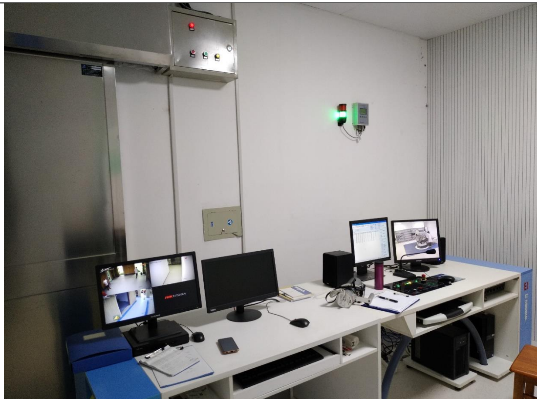
伽玛刀控制室内声光报警装置、视频监控、固定式辐射监测系统
