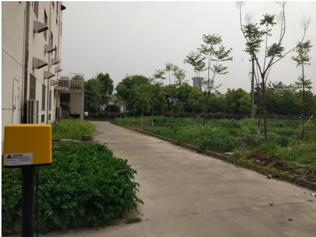
图 8 变电站周围的植被恢复
