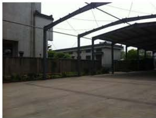
图 3-1、集团水泵房和门卫值班室
