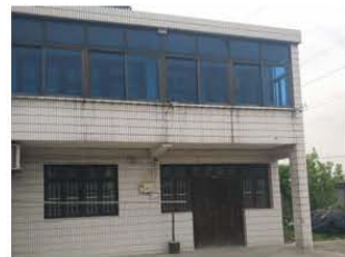
图 3-54、东陆家巷 31 号居民房
