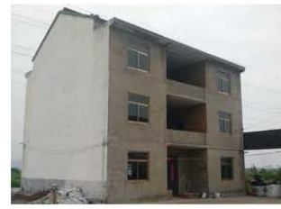
图 3-12、袁家巷袁姓居民家
