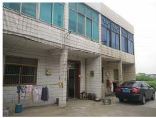
图 3-13、袁家巷 80 号居民房
