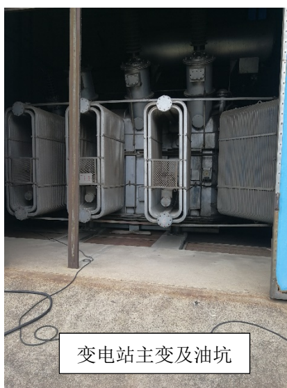
图 7 主变、油坑、事故油池
