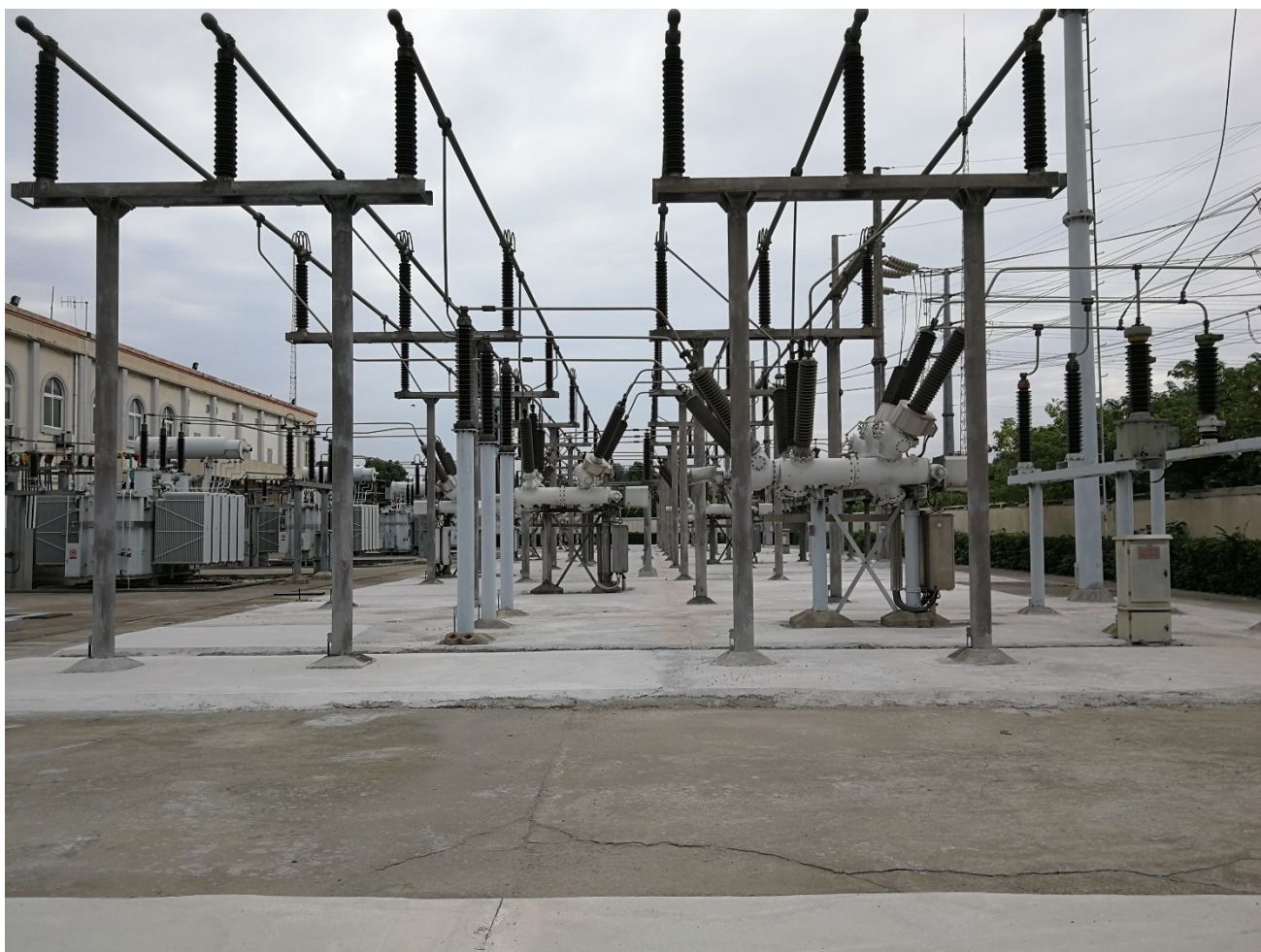
图 5 站区地面水泥硬化
