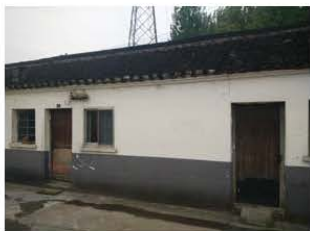
图 3-49、朱家楼下村 73 号居民房
