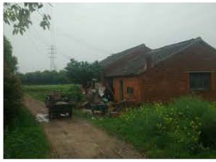
图 3-10、李家巷李姓居民家
