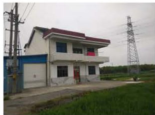
图 3-53、东陆家巷 53 号居民房
