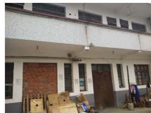
图 3-48、朱家楼下村 71 号居民房
