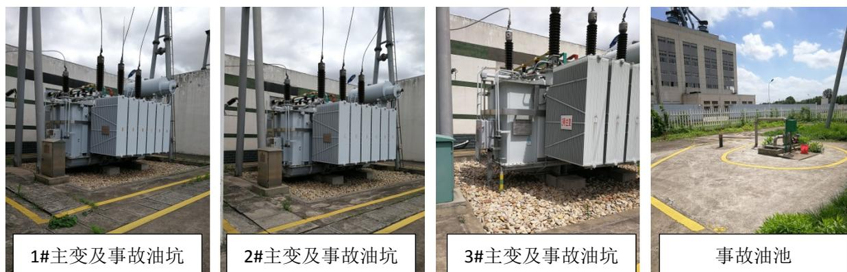
图 7 主变及下方事故油坑、事故油池
