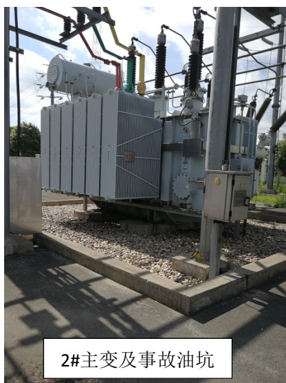
图 8 主变及下方事故油坑、事故油池
