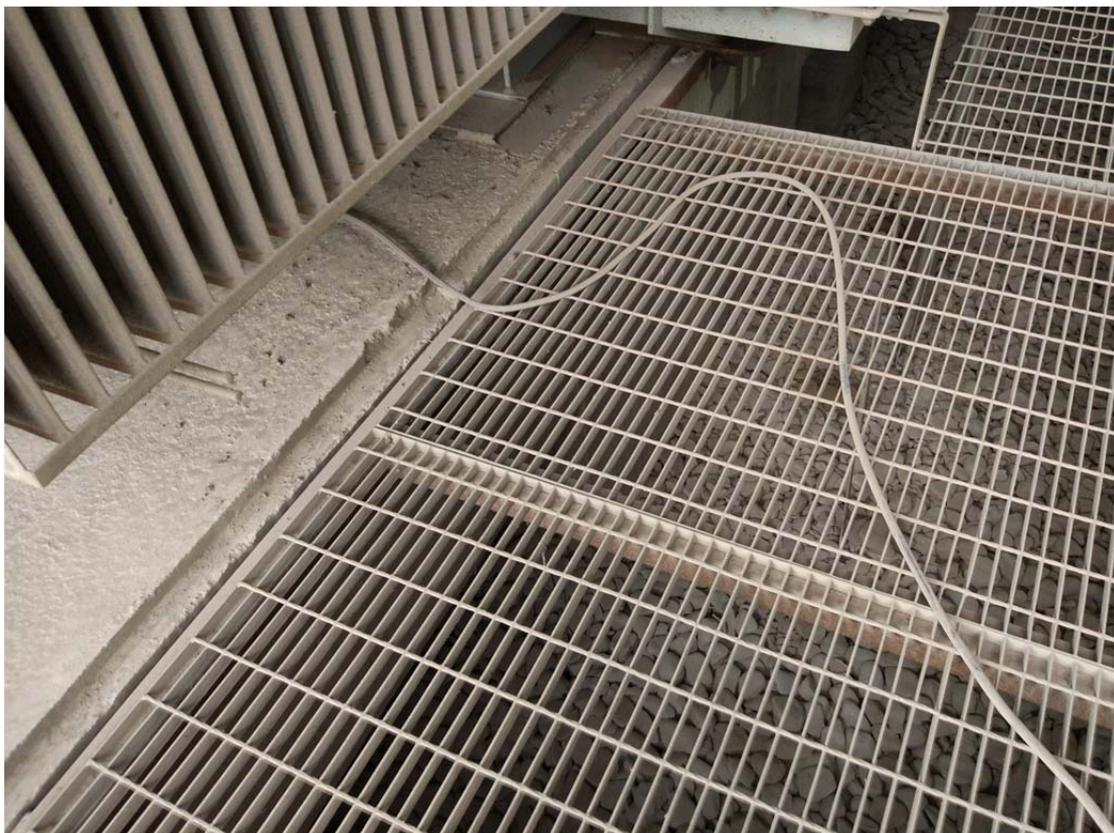
图 10 2#主变及下方事故油坑
